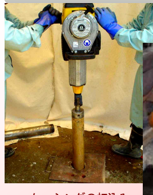
ケーシングの打込み
