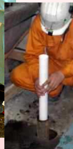
観測井戸設置
